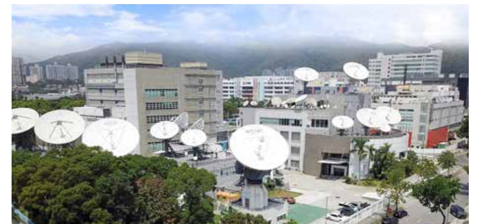
亚太公司大埔数据中心以及配套设施建设
